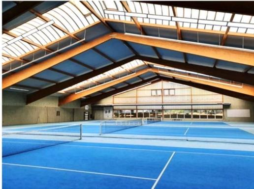
**3-Feldhalle - Spielklasse II (500 lx) – dem Dachverlauf folgendes Lichtband – Lichtsteuerung (DALI) – Anbindung an Buchungssystem**
