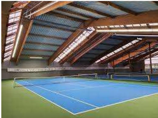
**3-Feldhalle - Spielklasse II (500 lx) – dem Dachverlauf folgendes Lichtband – Lichtsteuerung (DALI) – Tageslicht und nutzerabhängig**
