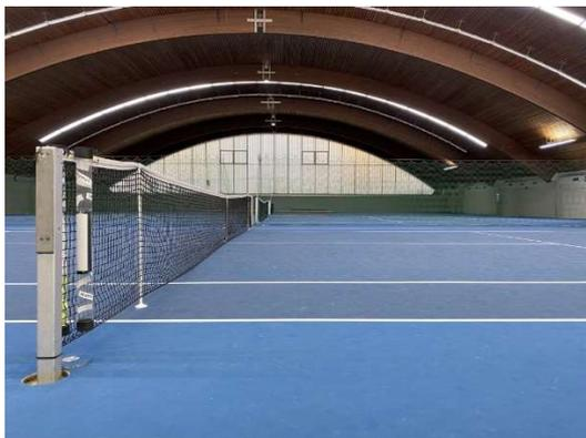
**3-Feldhalle - Spielklasse I (750 lx) – dem Deckenverlauf des Tonnendachs folgende Beleuchtung mit eigens entwickelter Halterung, um die Beleuchtung der Wölbung des Daches folgen zu lassen und gleichzeitig zum Spielfeld geneigt zu sein - DALI**
