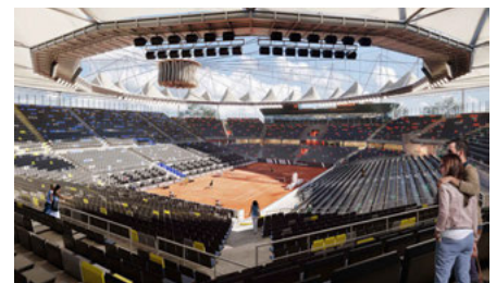
Blick in das Stadion am Hamburger Rothenbaum, das ein neues Dach bekam
