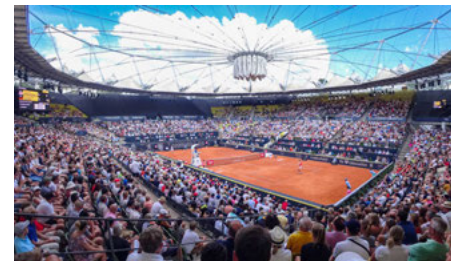
Das neue Dach am Rothenbaum-Stadion ist schon montiert
