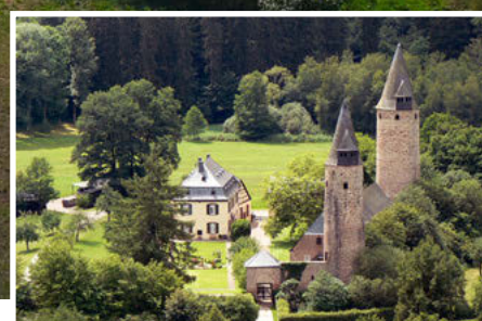
Mehr als 30 Meter hoch ragen die beiden Rundtürme von Burg Bruch an der „Säubrenner-Route“. Eine bis zu 1,60 Meter dicke Mauer schließt die Anlage ein. Foto: djd/Moseleifel Touristik
