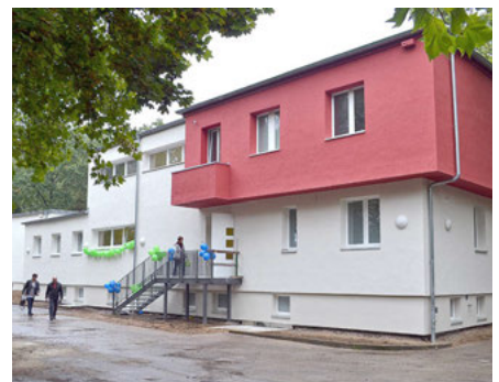
Das sanierte ehemalige Clubhaus des Berliner Schlittschuh-Clubs beherbergt jetzt das Prosportstudio Charlottenburg von Pro Sport Berlin 24
