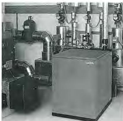
Das für Tennishallen geeignete Klein-Blockheizkraftwerk
