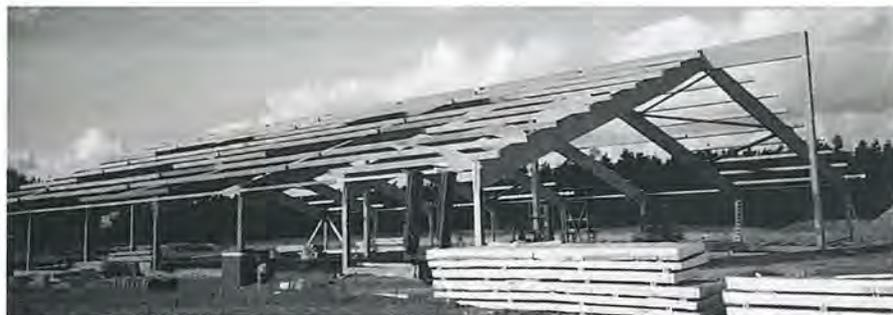
Sechs Wochen nach Baubeginn steht bereits die Dachkonstruktion der Tennishalle Reinke in Cottbus
